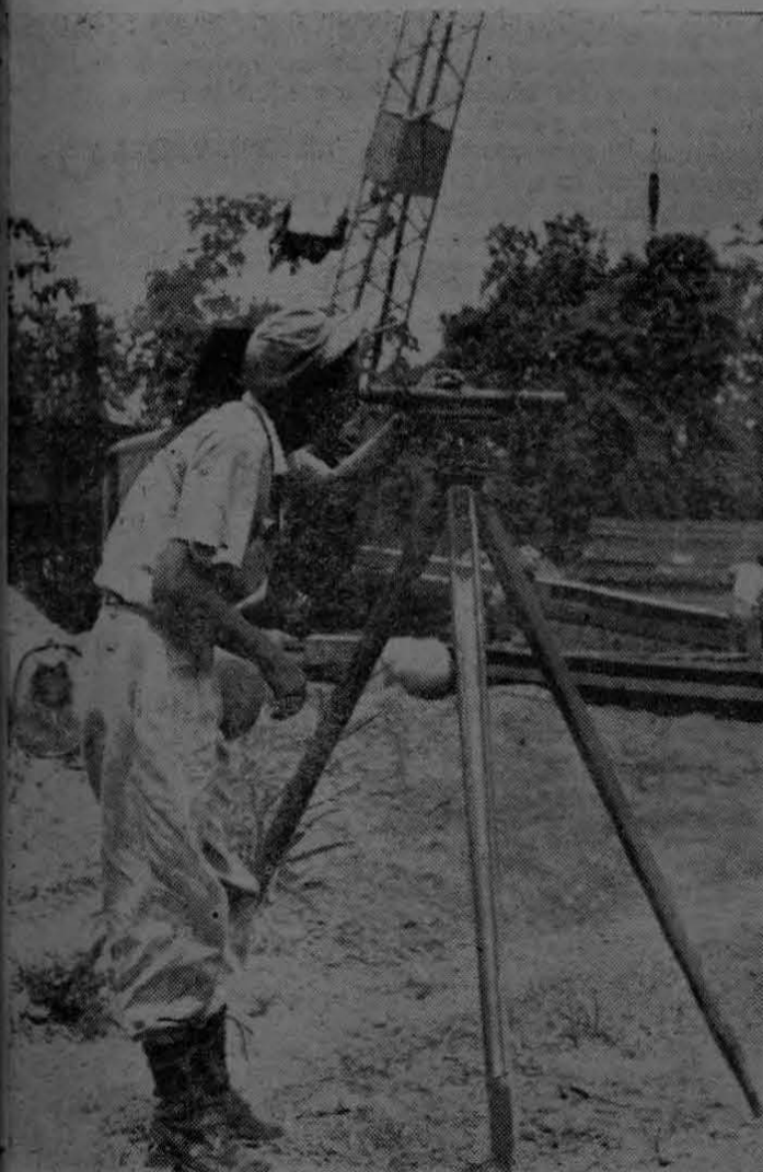
Alejandro Urtecho, del Departamento de Ingeniería de Coto, Sección de Puentes, toma cuidadosamente un nivel para colocar uno de los pilotes que soportará uno de los varios puentes que se construyen en las nuevas fincas de Coto.
