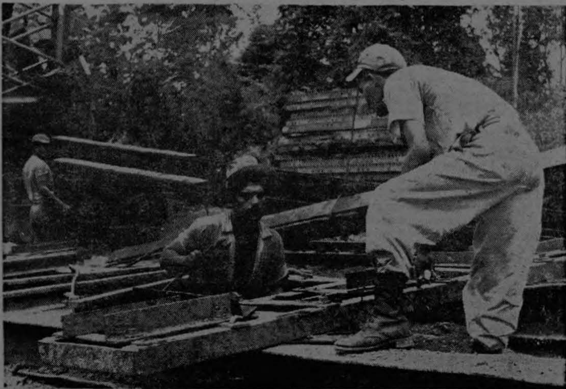
Juan Alfaro con una enorme llave fija, escucha las instrucciones de Alejandro Urtecho, del Departamento de Ingeniería de Coto, al comenzar a armar las secciones de uno de los nuevos puentes que se construyen en Coto para habilitar las nuevas fincas que se forman.
