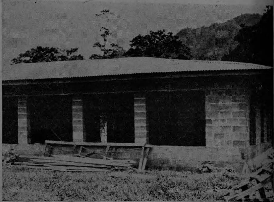
Avanzan los trabajos de construcción del edificio del Colegio de Segunda Enseñanza de Palmar Norte. Este es un aspecto del estado en que halla el ala Este de ese centro educativo que una vez terminado representará una inversión de más de 400.000 colones y está siendo levantado por la generosa contribución de los vecinos de la zona bananera del valle del Terraba, especialmente, de Palmar Norte y Sur.
